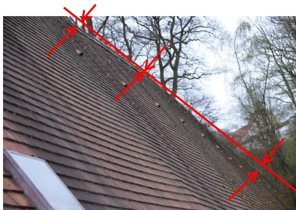
Bedingt durch die Instabilität des Daches sind Spannungen aufgetreten, die zu Rissen in der Mauer- und Deckenkonstruktion unserer Kirche geführt haben. Auch diese bautechnischen Mängel müssen nach der Erneuerung des Daches behoben werden.
