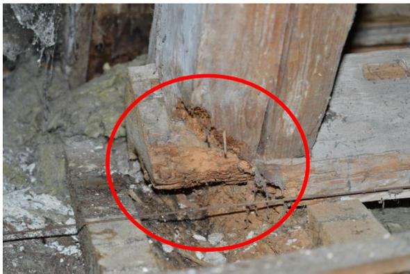
Durch diese Fäulnisbeschädigungen ist die Dachkonstruktion insgesamt instabil geworden.
