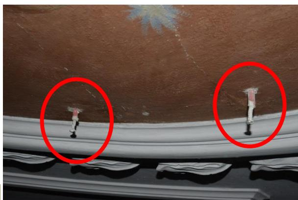
Teilweise waren die Deckenbilder nicht mehr fest mit dem Untergrund verbunden. Dadurch haben sich im Laufe der Jahre auch Risse gebildet. Diese Schäden wurden durch Einspritzen eines „Klebers“ jetzt behoben.
