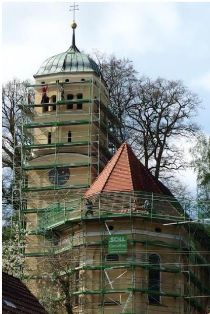
Im Außenbereich wächst das Gerüst zum Himmel. Kirchenschiff und Turm sind mittlerweile vollständig vom Außengerüst umgeben. Dies ist Voraussetzung dafür, dass die Arbeiten am Dach beginnen konnten.
