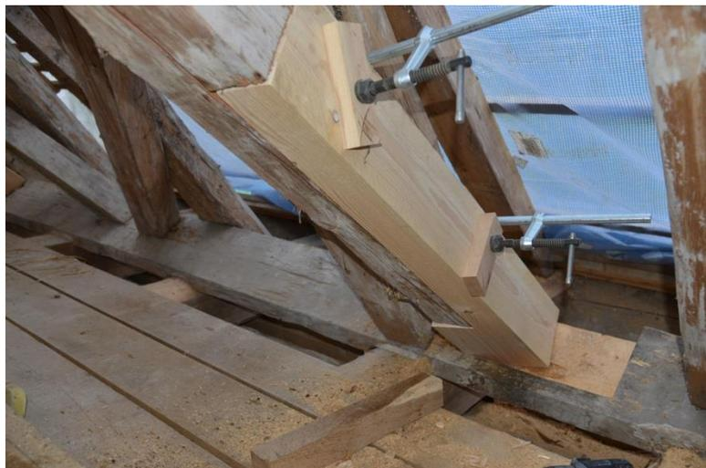
Bei der Reparatur der defekten Dachkonstruktion wird sehr behutsam vorgegangen.
