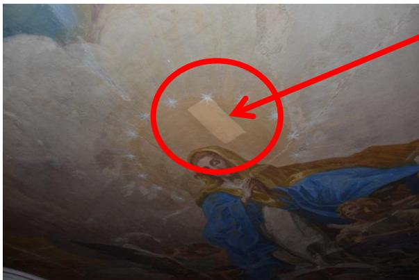
Hierzu wurden zunächst einige „Probereinigungen“ an verschiedenen Stellen vorgenommen. Diese Reinigung ist besonders behutsam durchzuführen, damit die Bilder dadurch nicht zerstört werden.
