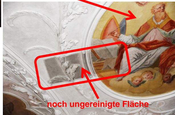
Auch bei der jetzigen Restaurierung ist es Aufgabe des Kirchenmaler, den Stuck und die Bilder zu fixieren; hohle Stellen werden dabei durch Einspritzen eines Klebers wieder fest mit der Unterkonstruktion verbunden und somit gesichert.
