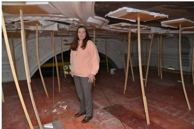
Eine der wichtigsten und ersten Maßnahmen war die Sicherung der Decke. Nachdem unmittelbar darüber an der Reparatur der Dachkonstruktion gearbeitet wird, müssen Stuck und Deckengemälde gegen Erschütterungen geschützt werden.
