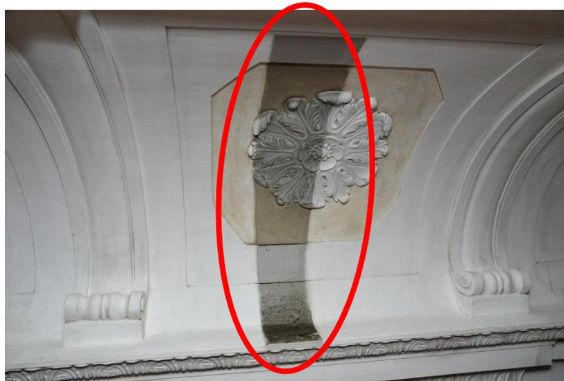
Zunächst wurden nun Decke und Wände abgewaschen. Allein durch diese Maßnahme wurde sichtbar, wie weit fortgeschritten die Verschmutzung der Wände, aber auch des Stucks, der Fresken und Figuren schon war.
