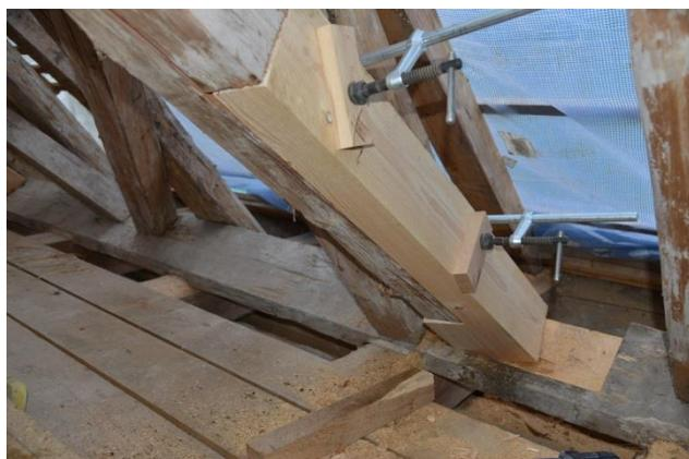
Die Arbeiten am Dachstuhl schreiten auch mit großen Schritten voran. Bei der Ausbesserung bzw. Erneuerung der Balken wird sehr behutsam gearbeitet.
